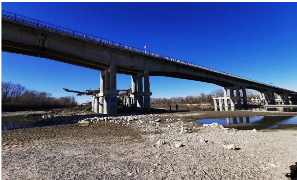
*Figura 38 - Accumulo di detriti legnosi di notevoli dimensioni in corrispondenza delle pile del ponte di Boretto*
