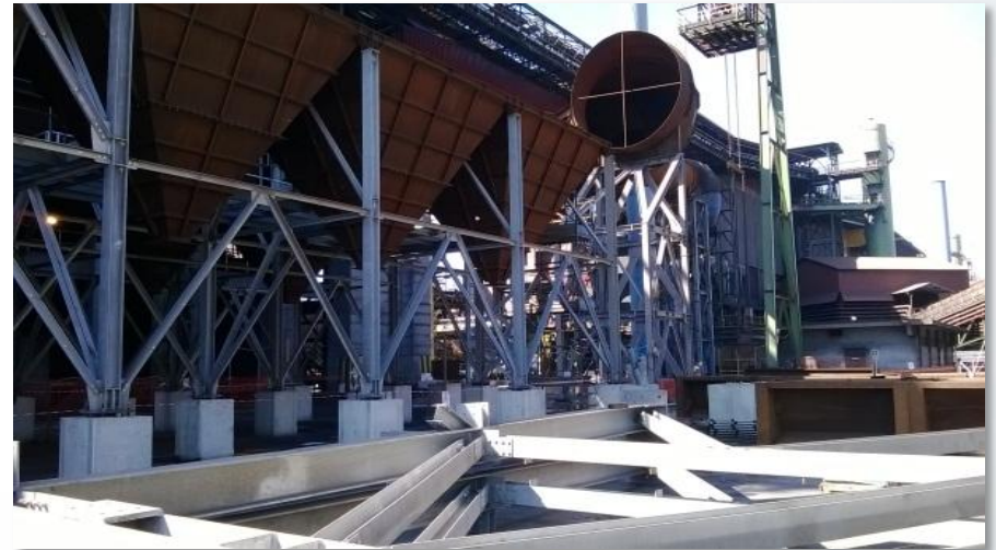
Inizio del montaggio dei filtri del sistema depolverazione
