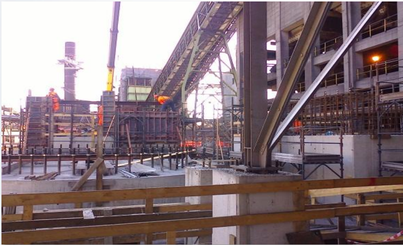
Basamenti sistema di depolverazione della stock-house dell' AFO2
