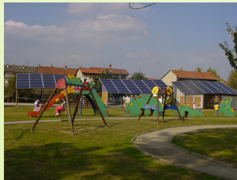
Foto: parco pubblico con fotovoltaico, Comune di Settimo Rottaro (TO)
