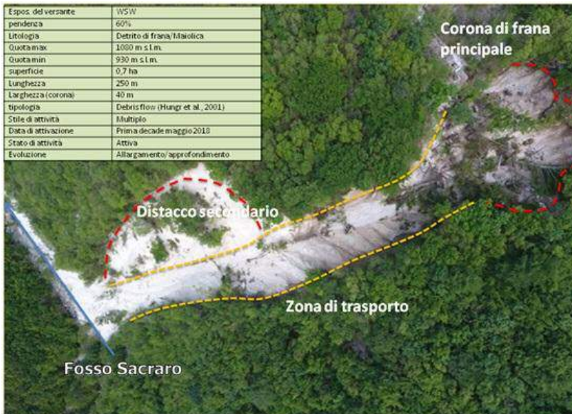
Figura 2: Corona principale, zona di trasporto e di scorrimento del fenomeno franoso che ha provocato nel maggio '18 il danneggiamento e l'interruzione del sentiero E4
