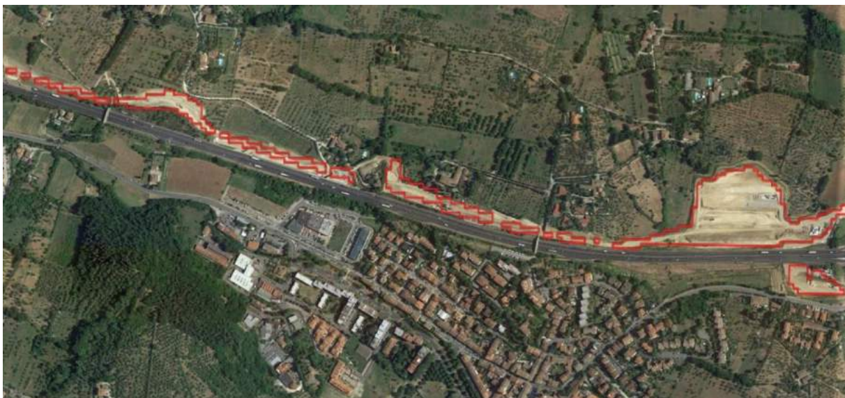
Figura 71 - L'avvio della realizzazione, tra il 2016 e il 2017, della terza corsia dell'autostrada A1 (l'Autostrada del Sole), nel Comune di Bagno a Ripoli (Firenze), ha comportato un consumo di suolo di oltre 8 ettari.
