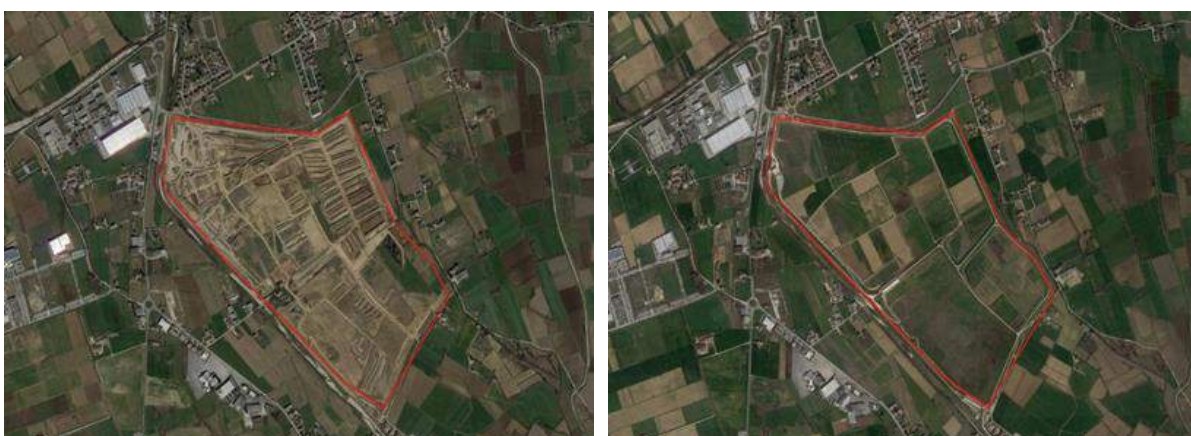
Figura 51 - Esempio di recupero di suolo a seguito del ripristino delle aree di cantiere per la creazione delle casse di espansione per il Torrente Timonchio nel comune di Caldogno (VI): l'area dell'intervento è di circa 114 ettari (immagini 2015 a sinistra e 2017 a destra).
