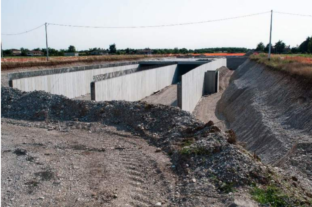
Figura 1 - Un esempio di nuova copertura artificiale del suolo dovuta alla realizzazione di un'infrastruttura, la superstrada Pedemontana Veneta a Trevignano, in provincia di Treviso (foto di Alberto Sfoggia)
