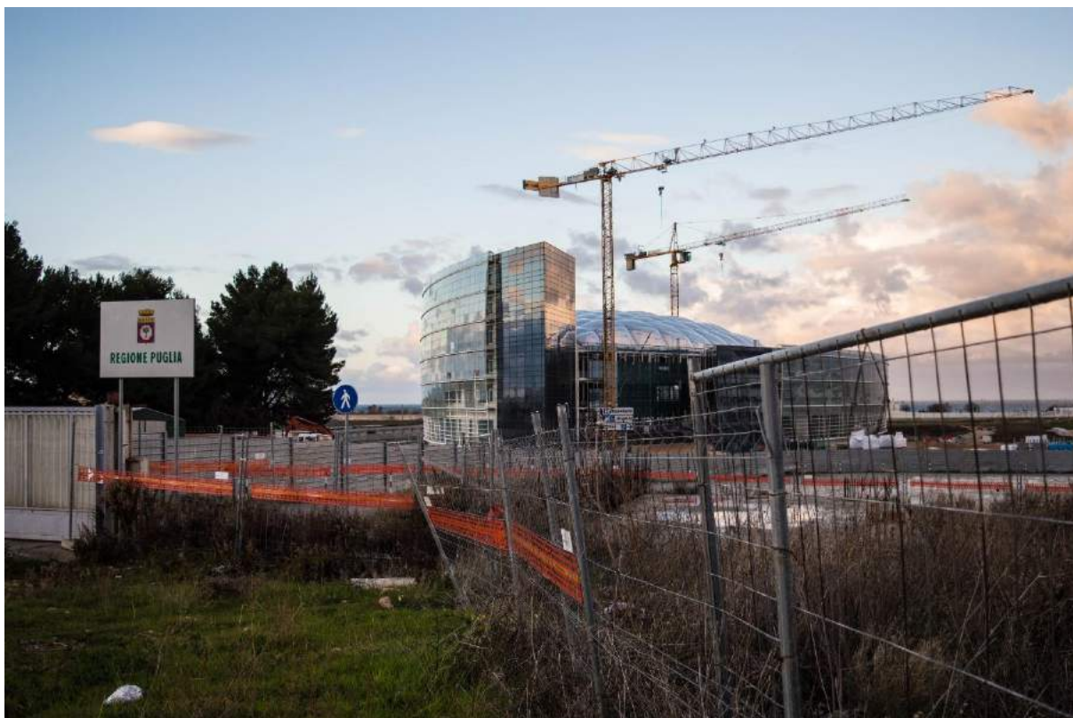
Figura 98 - La realizzazione della nuova sede della Regione Puglia a Bari (foto di Camilla Piergiovanni)
