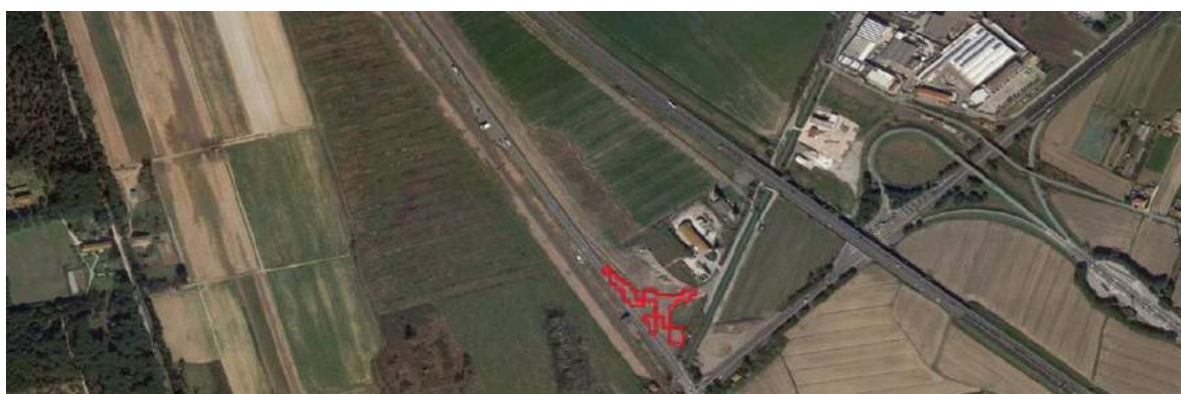
Figura 73 - A seguito dell'alluvione verificatasi in Provincia di Pisa nel 2016 è stato messo in opera il raddoppio della strada statale Aurelia nel Comune di Vecchiano, la cui dismissione avverrà verosimilmente nell'arco di pochi anni. Nel caso in oggetto il nuovo consumo di suolo, pur presentando tutte le caratteristiche per essere classificato come non reversibile, è destinato alla rimozione a seguito della dismissione dell'infrastruttura.
