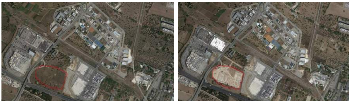
Figura 94 - Un nuovo quartiere a destinazione principalmente residenziale nella periferia di Bari. L'intervento ha richiesto un'occupazione di suolo di circa 6 ettari, pari a un terzo della quota totale del comune.
