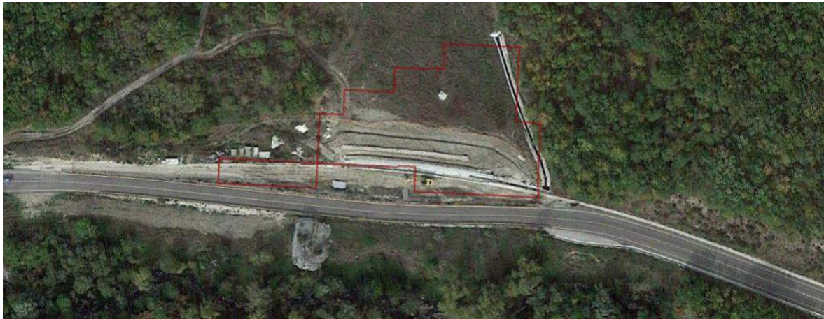
Figura 88 - Cantiere lungo la Strada Provinciale 160 a Campobasso (4.200 m 2 ). Nel capoluogo molisano (55 km 2 ) si è registrato un aumento di consumo di suolo di quasi 4 ettari. Oltre 13.000 m 2 sono attualmente occupati da un cantiere, mentre 10.000. m 2 sono stati persi per la realizzazione di due complessi residenziali.
