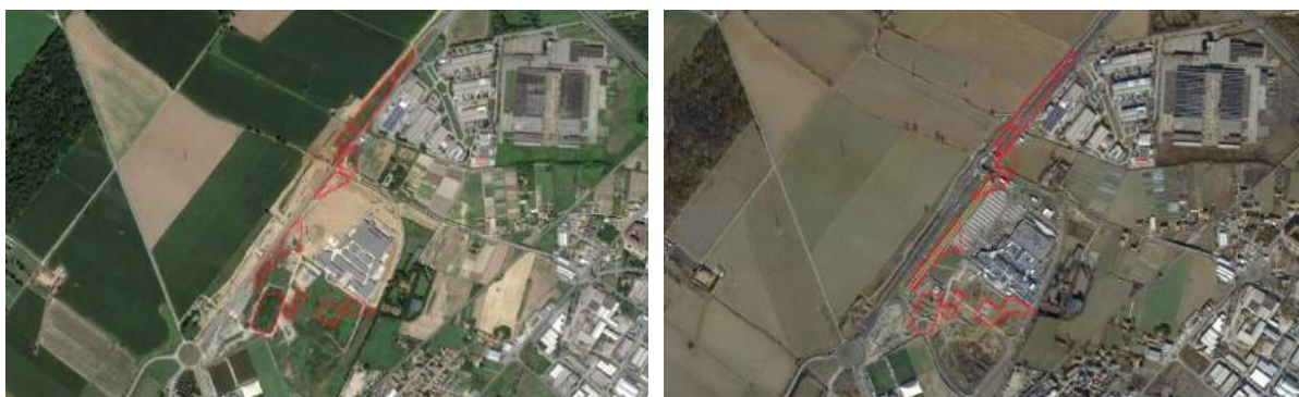
Figura 33 - Cantiere nell'area commerciale a cavallo dei territori di Nichelino e Vinovo e il raddoppio e completamento della nuova strada Debouché, intervento infrastrutturale di 37.000 m 2 che collega i due centri abitati in provincia di Torino, ha condotto alla recente occupazione di suolo pari a 4 ettari.
