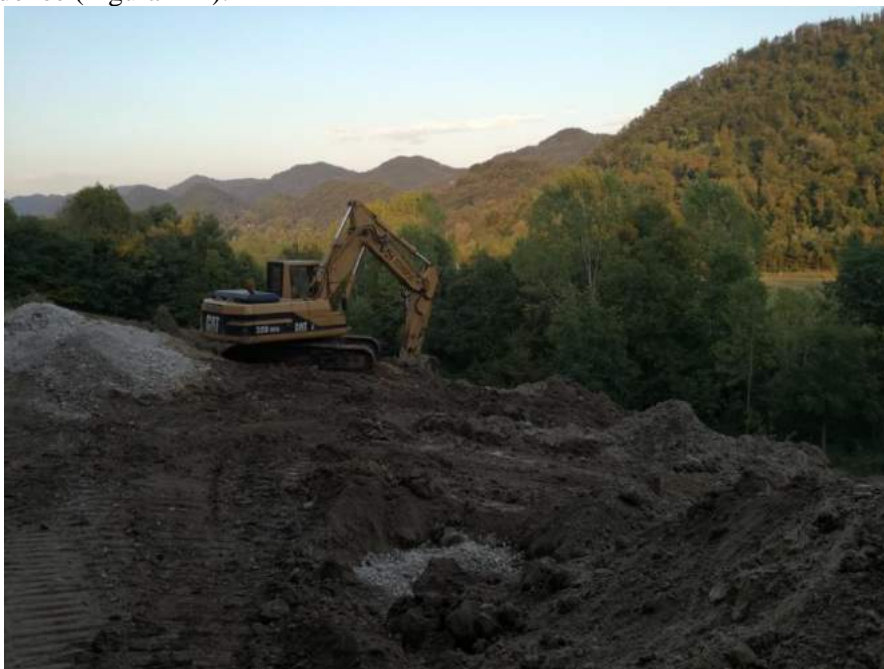
Figura 222 - Modificazioni geomorfologiche per l'impianto di nuovi vigneti nelle aree collinari della zona DOCG. Fonte: foto dell'autore
