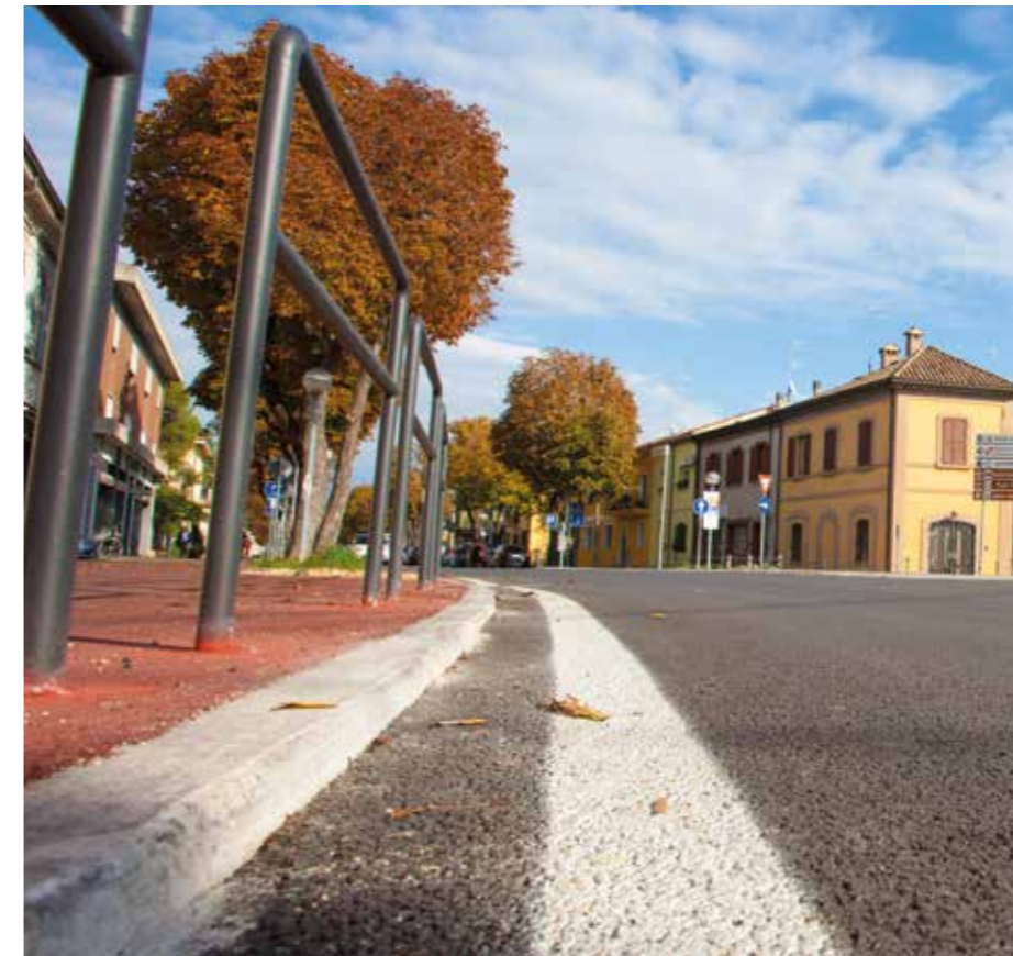
Rimini, via Marecchiese. Stesa di pavimentazione con polverino di gomma riciclata con abbattimento a bordo strada della rumorosità dei veicoli in transito a 50 km/h di circa 5 dB(A) rispetto allo stato anteoperam.
